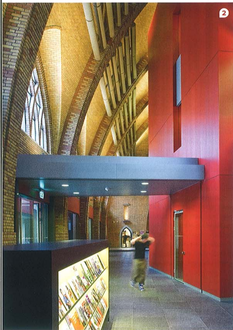
1 // De knalrode borstweringen zijn gevuld met minerale wol en aan de binnen- en buitenzijde afgewerkt met bamboe acoustics beplating. Alle plafonds zijn uitgevoerd met Ecophon-platen. Door de plafonds indirect aan te lichten, kijk je vanuit de kerkruimte niet steeds in de armaturen. 2 // De vluchtweg uit het kantorenblok naar buiten is voorzien van een vast plafond, waaruit brandwerende doeken zakken in geval van brand.
